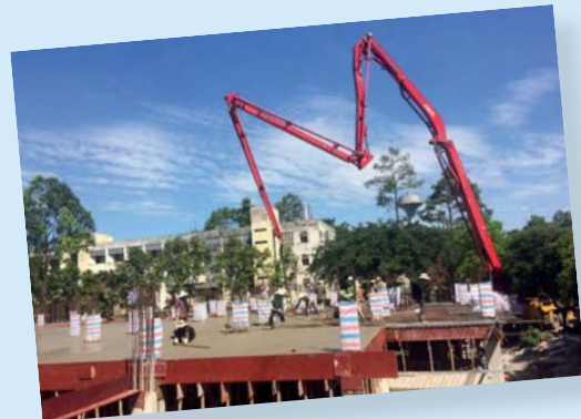
Baufortschritt beim „Hospitaller Home“ seit Sommer 2017 (von oben nach unten)
